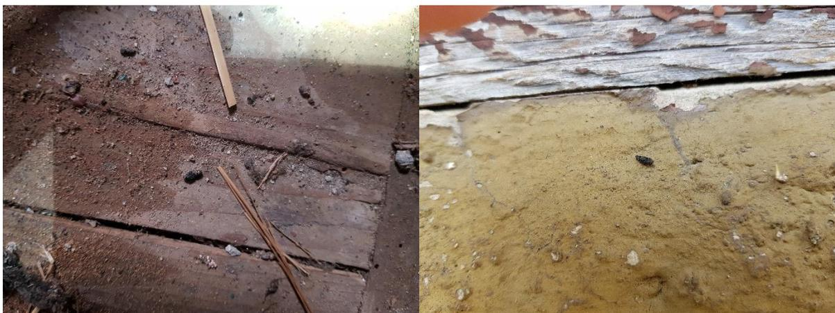
**Abb. 2:** Beispiele der Kotspuren im Bereich des Dachstuhls (rechts) sowie an den Außenwänden (links) durch Fledermäuse.
